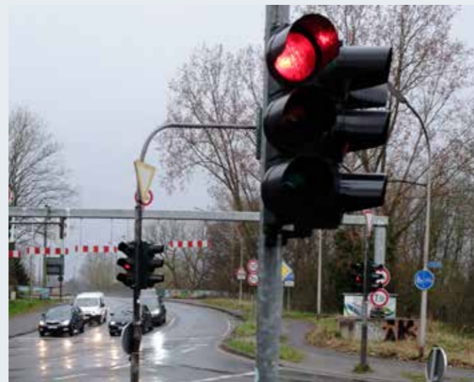
Die Ampel für den Brückenneubau steht nach wie vor auf „Rot“. Das wird auch noch für längere Zeit so bleiben.
