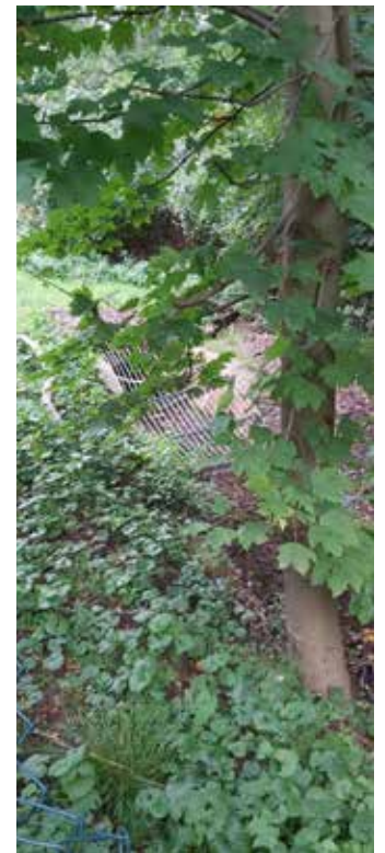
Die Schmalenbecke in Wengern wird umgestaltet - im Oktober hat der zweite Bauabschnitt begonnen.
