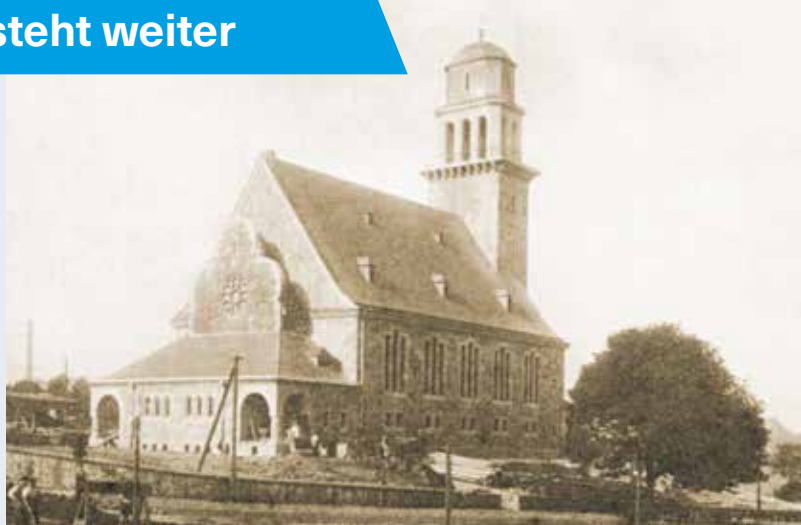
Ein historischer Blick auf die Hiltroper Erlöserkirche.
