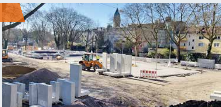
Die Bauarbeiten am Werner Markt schreiten voran.
