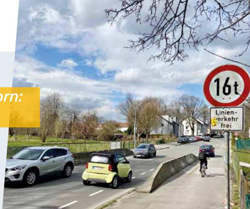
Die Brücke über den Crengeldanzgraben wartet seit Jahren auf eine umfangreiche Sanierung, die vor allem die Traglast erhöhen und das Befahren von Lkw wieder möglich machen soll. Foto: Nolte
