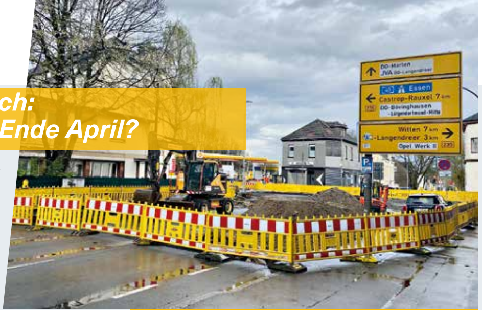
Der Kreuzungsbereich von Provinzialstraße und Lütgendortmunder Hellweg ist noch immer eine Großbaustelle. Foto: Nolte
